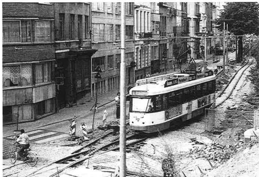
PCC 7013 in de Mercatorstraat komend vanuit de premetro-uitgang op 13 september 1999. Duidelijk te zien is de kruising waarna de tram terug rechts gaat rijden. Na de NMBS-werken verdwijnt deze kruising en komt de tram richting premetro terug naast de spoorwegberm. Foto : Luc Couscheir
