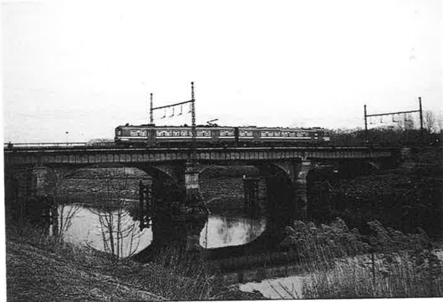
Stel 746 rijdt op 15/2/98 over de Netebrug te Duffel als IR-trein Poperinge - Turnhout. Aan de brugpijlers is duidelijk te zien dat deze brug oorspronkelijk voor twee sporen is geconstrueerd en dat zijdelings naast de eigenlijke brug nog een extra brugdek is aangewerkt. Deze metalen brugdekken laten geen zijdelingse verplaatsing toe i.v.m. het verhogen van de lijnsnelheid, waarvoor het tussenspoor dient verruimd te worden. Een nieuwe brug over de Nete staat voor lijn 25 op het programma. Foto : Erik Heylen.
